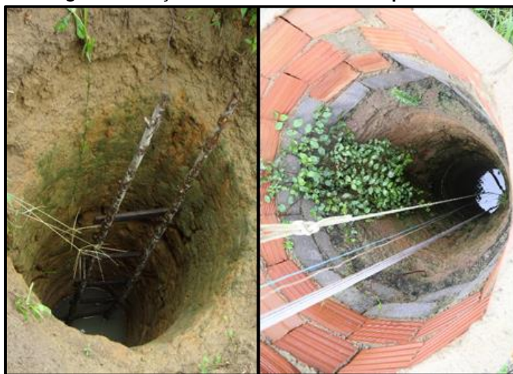
Figura 5 - Poços rasos com estruturas precárias
