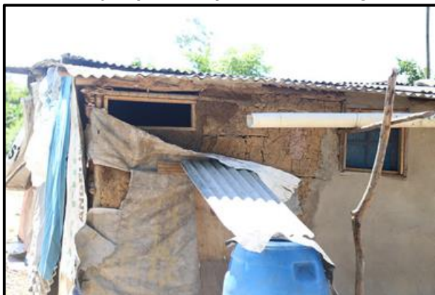
Figura 6 - Solução precária para coleta de água de chuva
